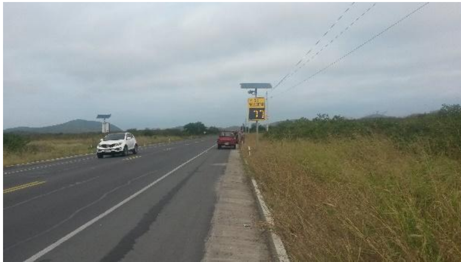
Figura 2. Tipo de Panel de Control de la velocidad en una carretera principal
