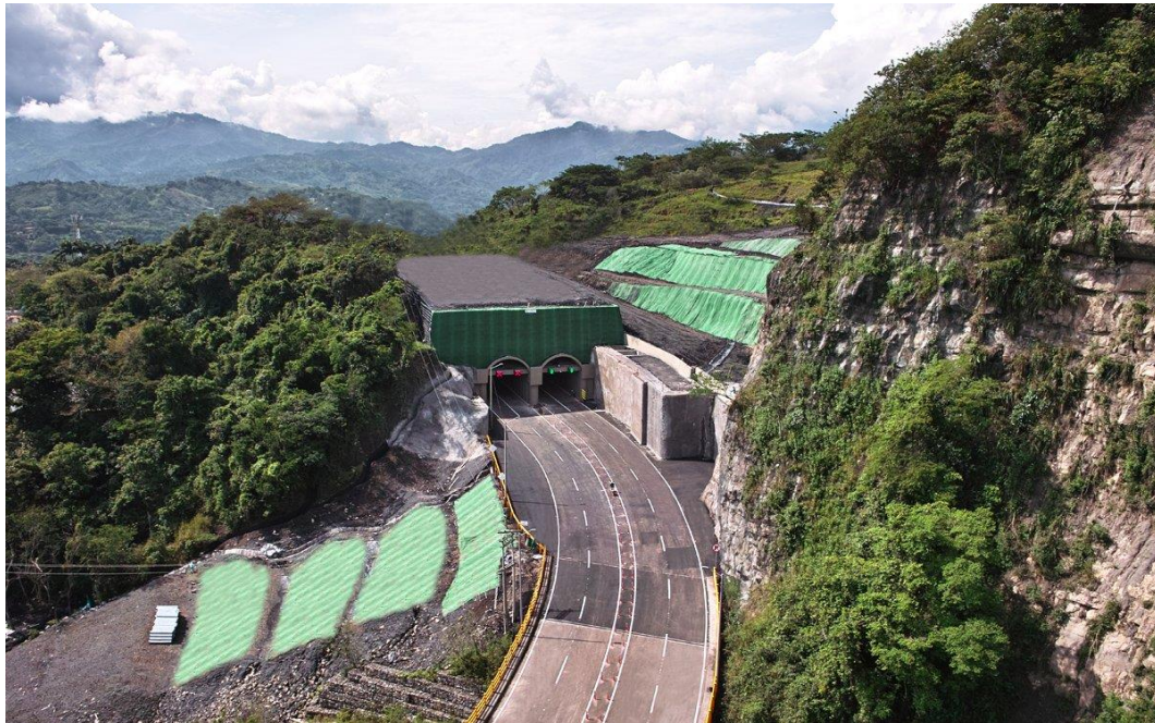
Figura 1. Falso Túnel el Cune.
