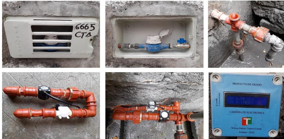
Figura 6. Instalación de la Infraestructura de medición
